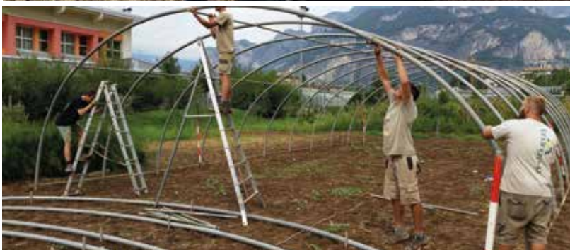
Realizzazione della serra - tunnel
